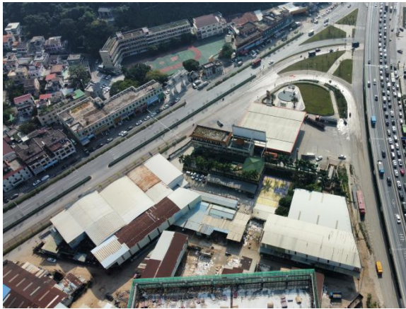
项目南面（工业厂房）
